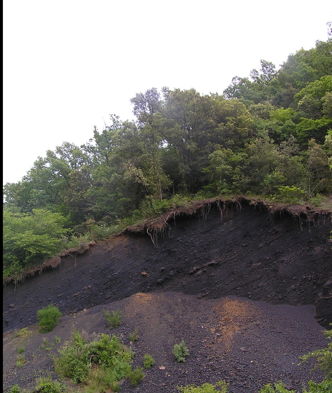
Deslizamiento en piroclastos, en La Garotxa, San Pau. SW Hoja de Olot (por Iulian Barcelona-Google)
